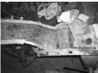
...von Typreferent Kai Steude. Was darunter zu verstehen ist, zeigt dieser herausgetrennte Träger
