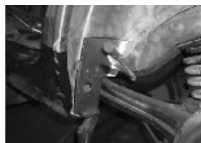
Die Reparaturbleche, fixiert
